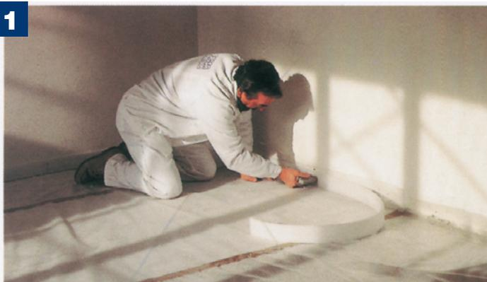
En absence de prescriptions particulières il est nécessaire d'étaler, sur toute la surface à réaliser, des films en polyéthylène en chevauchant les jonctions sur 25 cm au moins et en les relevant en périphérie sur les parois. Placer, tout le long des parois et autour des éléments verticaux, une bande compressible ayant une épaisseur de 0,7 à 1 cm et une hauteur correspondant au moins à celle de la chape à réaliser.
