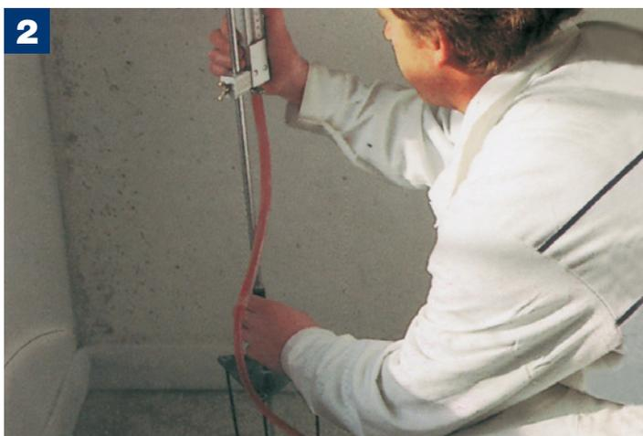
Pour garantir la planéité de la coulée, placer des repères de niveau spécifiques et prédisposer des arrêts de coulée si nécessaire. Fractionner la chape au droit des ouvertures dans les parois ou des parties saillantes, en insérant un élément de séparation pendant la pose ou en sciant la chape après son durcissement.
