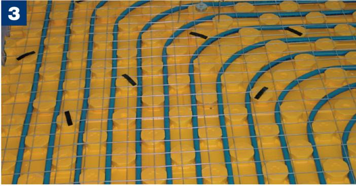
Dans le cas de sols chauffants, positionner un treillis métallique à l'intérieur de la chape, en veillant à le fixer aux panneaux d'isolation. Le treillis, avec maille de 50x50 mm ou 50x80 mm et épaisseur du rond 2 mm, doit être interrompu au niveau des joints de retrait. La mise en œuvre sur des systèmes de chauffage par le sol n'exige pas l'adjonction d'agents fluidifiants car ils sont déjà contenus dans le produit.
