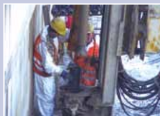
Fase 2 Alloggiamento dell'armatura del micropalo.
