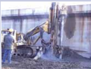
Fase 1 Perforazione (con utensile a rotocompressione, con spurgo del foro dei materiali detritici di risulta).
