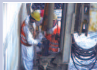
Phase 1 Forage (avec outil à rotation tel que tarière, avec extraction des résidus de forage).
