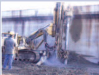
Phase 1 Forage (avec outil à rotation tel que tarière, avec extraction des résidus de forage).
