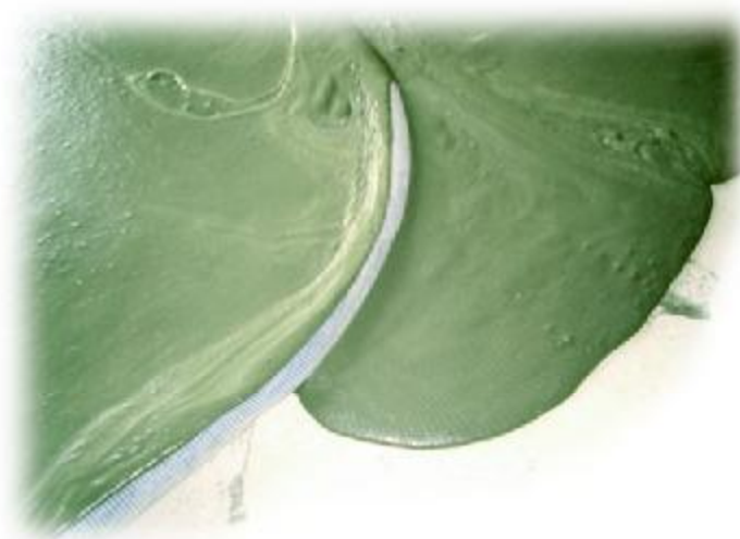
Calcestruzzo alleggerito in fase applicativa.
